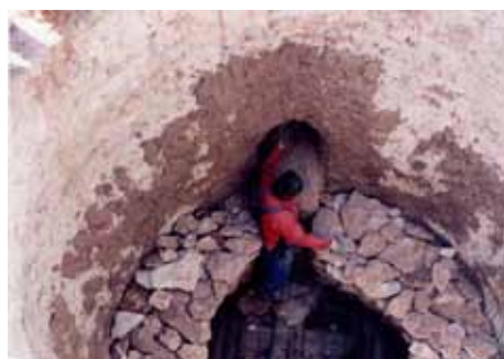
Fig. 65 : Coupole de cailloux de chaux
