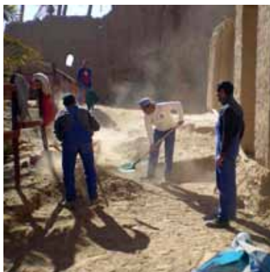
Fig. 7 : Dégagement de terre
