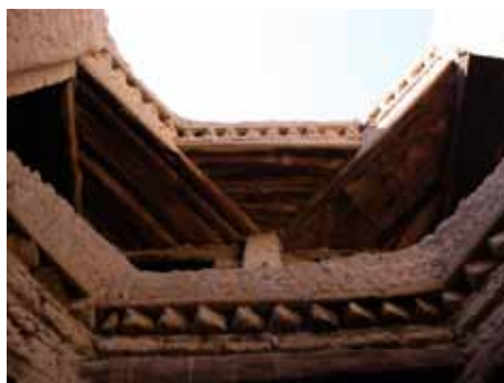
Une architecture utilisant les techniques et matériaux locaux (briques de terre séchées, bois du palmier, chaux)
