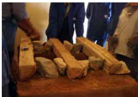
Fig. 34 : Échantillon d'un toit terrasse
