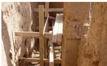
Fig. 29 : Deuxième niveau d'échafaudage
