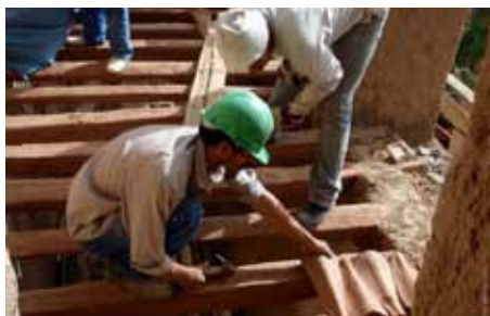
Fig. 39 : Pose des tiqechba
