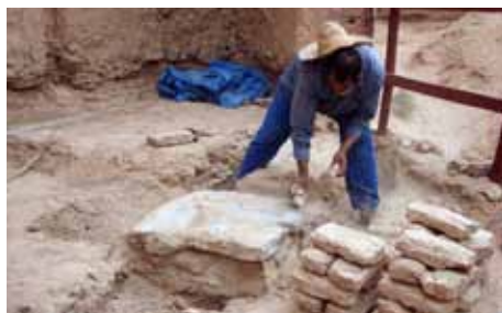
Fig. 17 : Nettoyage de la base
