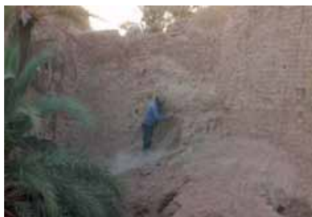
Fig. 48 : Préparation de l'arrière
