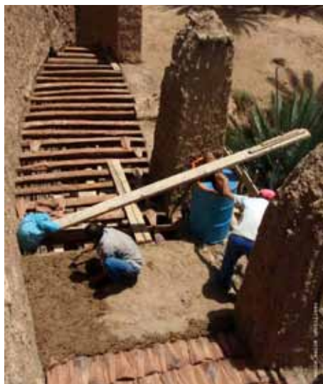
Fig. 43 : Pose de la chape
