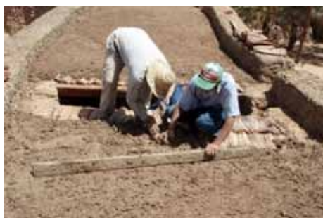
Fig. 54 : Étalement de la chape
