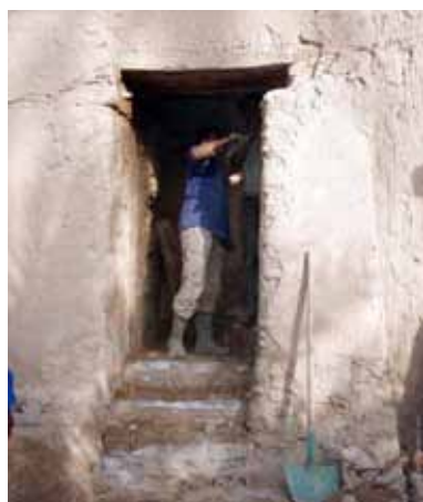
Fig. 44 : L'escalier de la tour
