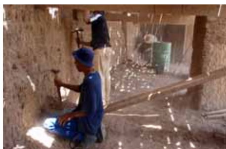
Fig. 61 : Piquage de l'enduit intérieur de la galerie
