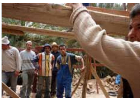
Fig. 23 : Montage de l'échafaudage...
