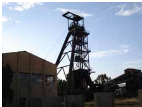
Puits 2: Salle des machines, Chevalement, Laverie
