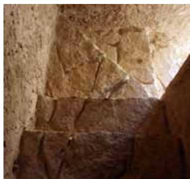
Fig. 46 : Le nouvel escalier en pierre
