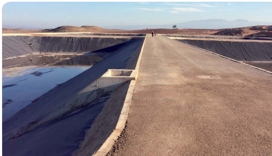
STEP de l'ONEE pour la ville de Ras El Ma cofinancée par la coopération belge
