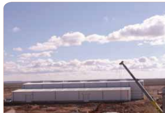
Atelier de stockage solaire
