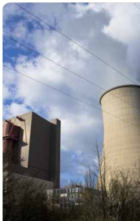
Les centrales thermiques : l'exigence de très gros équipements
