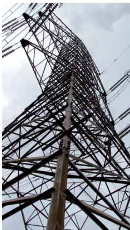
Les autoroutes électriques
