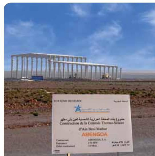
Premiers bâtiments pour la Centrale Thermo-solaire d'Ain Beni Mathar
