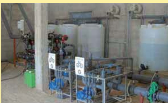
La nouvelle station de pompage
