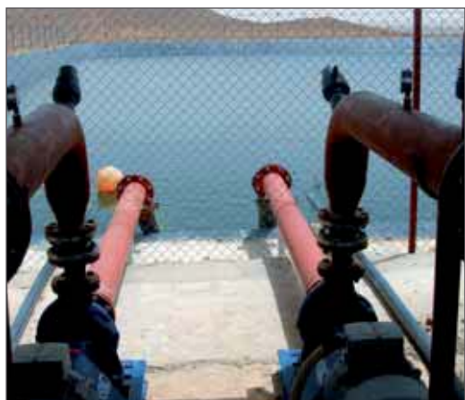
Nouvelle station de pompage et nouveau bassin
