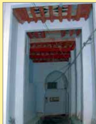
Restauration en cours au Ksar Al Maiz
