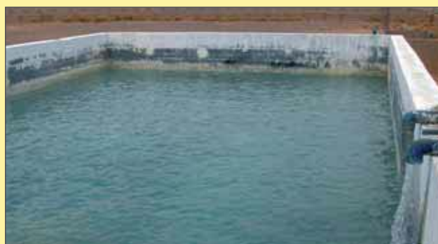
Le nouveau bassin sur l'extension
