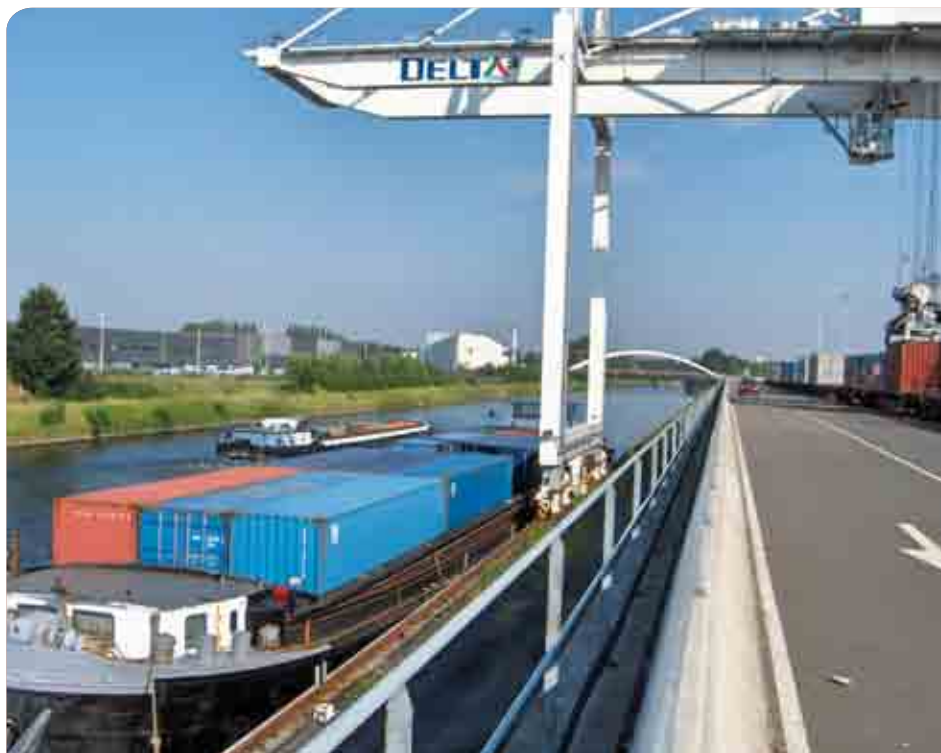
Du bateau au train, puis éventuellement du train à la péniche, des installations pour un transbordement simple et rapide
