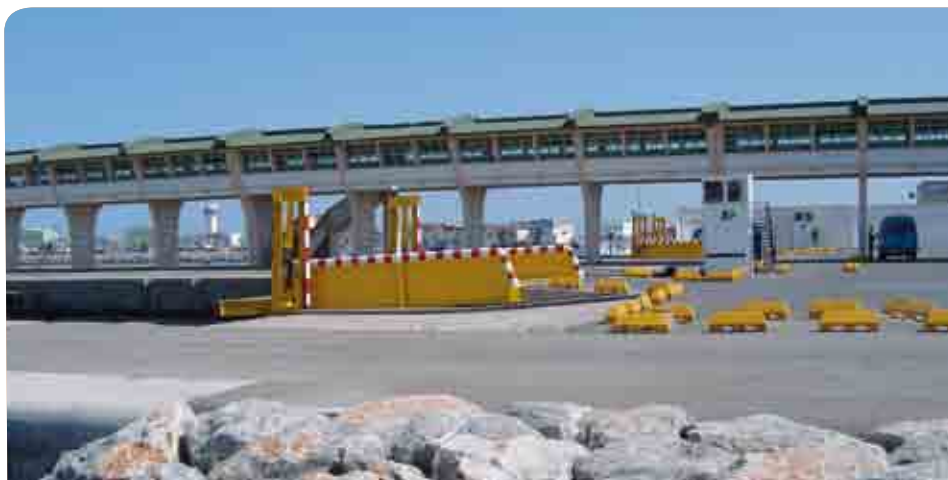
Port de Bni Ansar/Nador : des installations modernisées et bien dimensionnées
