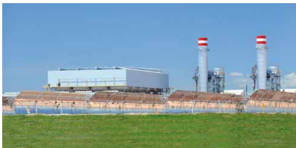
La nouvelle centrale thermo-solaire de Ain-Bni-Mathar, inaugurée le 12 mai 2010
