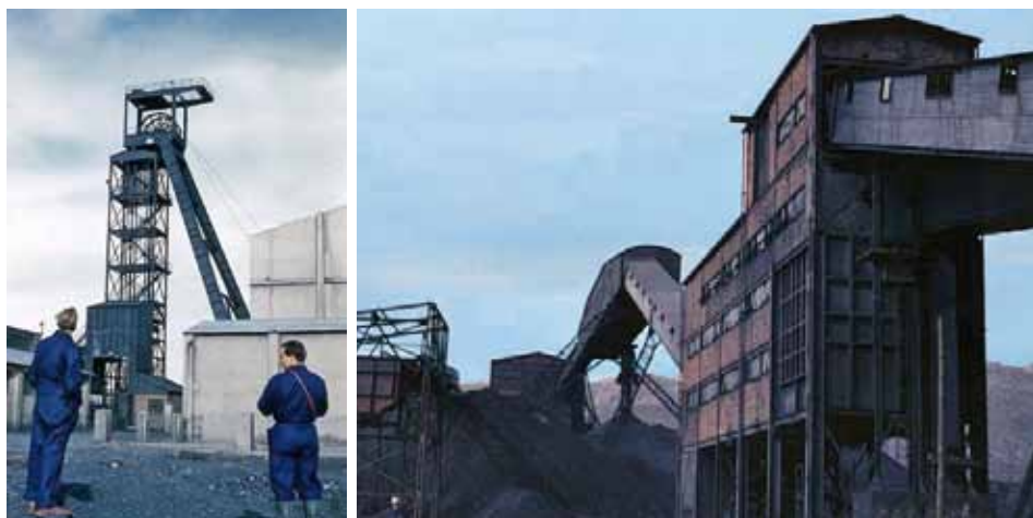
Chevalement et autres installations d'exploitation de la mine d'antracite de Jerada, aujourd'hui à l'abandon
