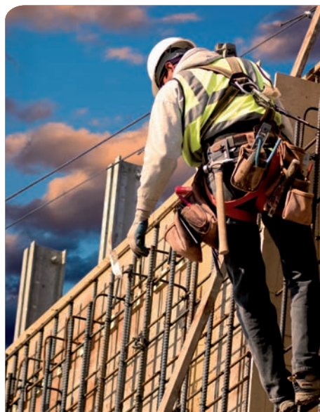
27% du dispositif de l'OFPPT dans l'Oriental est dédié à la formation dans les métiers du Bâtiment.
