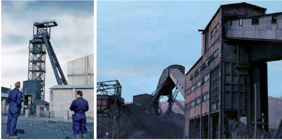
سقيفة ومنشآت أخرى تُستخدم في استغلال معدن الفحم الحجري لجرادة متخلى عنه حاليا
