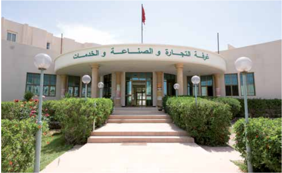
مقر غرفة التجارة والصناعة والخدمات بوجدة كلها يقظة ونشاط وخاصة لمحاربة اللامهيكل والتخريب
