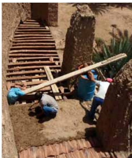
Fig. 43 : Pose de la chape
