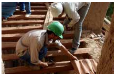
Fig. 39 : Pose des tiqechba
