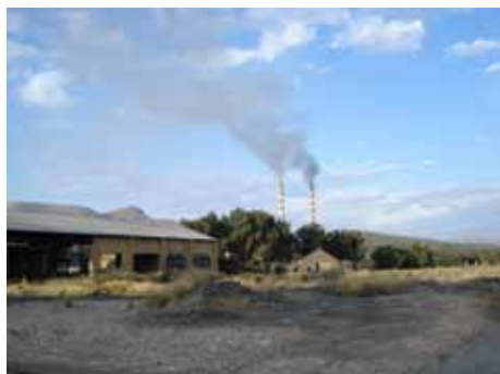
Baraquement de la « Salle des pendus » (vestiaire des mineurs) & cheminées de la Centrale Electrique
