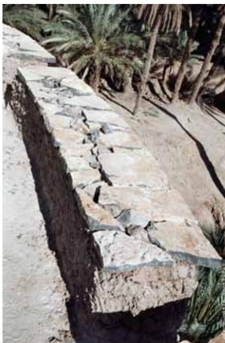
Fig. 53 : Acrotère de la terrasse
