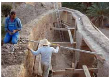
Fig. 52 : Niveau du 2ème plancher
