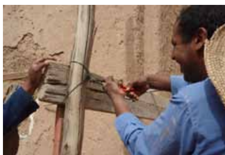
Fig. 22 : Montage de l'échafaudage...
