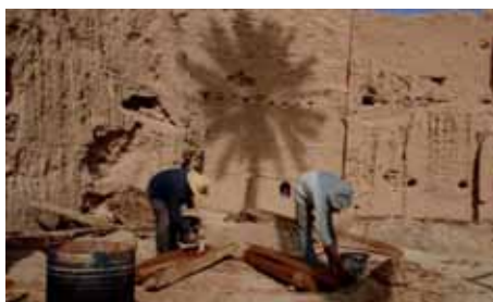
Fig. 28 : Traitement des tiziden
