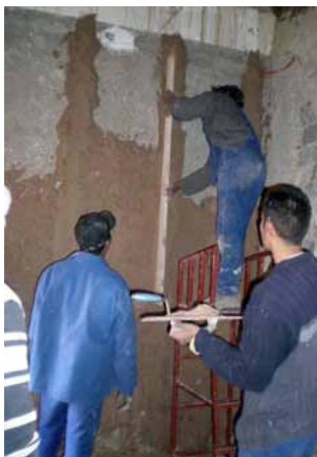
Fig. 59 : Dressage d'enduit
