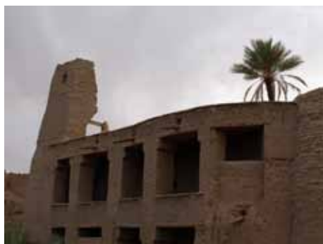
Exemple de travaux de restauration : la muraille d'Ajdir avec l'Agence de l'Oriental
