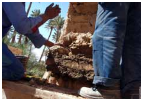
Fig. 32 : Restauration de la base d'un pilier
