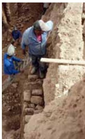
Fig. 50 : Reconstruction de l'arrière
