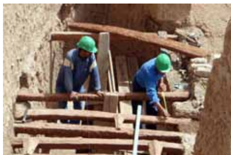
Fig. 36 : Pose des poutres du premier étage
