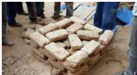
Fig. 18 : Montage à sec
