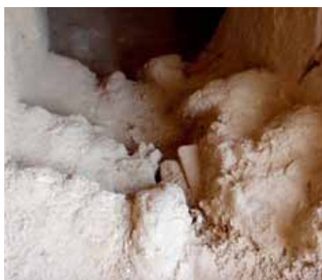
Fig. 45 : L'escalier avant réfection
