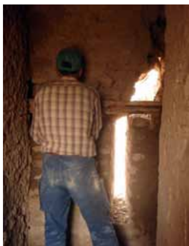
Fig. 56 : Reprise des fissures depuis l'intérieur
