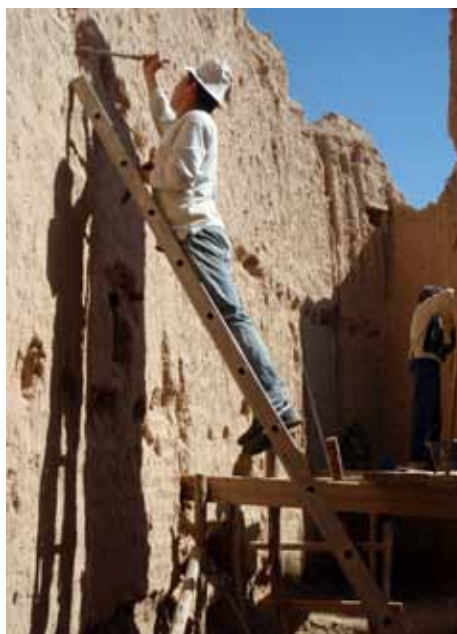
Fig. 12 : Mesure de l'épaisseur de la muraille
