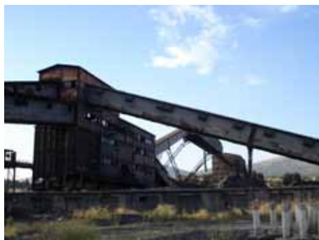
Jerada, Puits 2 : Laverie et bande passante
