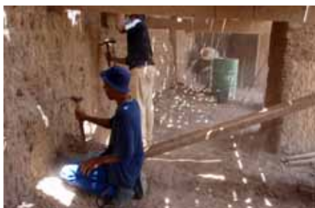
Fig. 61 : Piquage de l'enduit intérieur de la galerie
