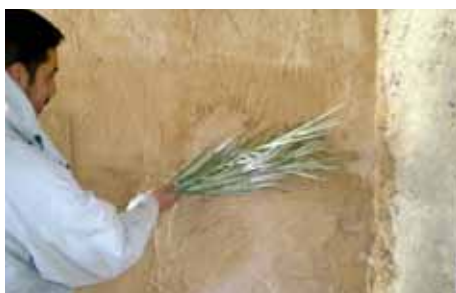
Fig. 60 : Lissage à la palme
