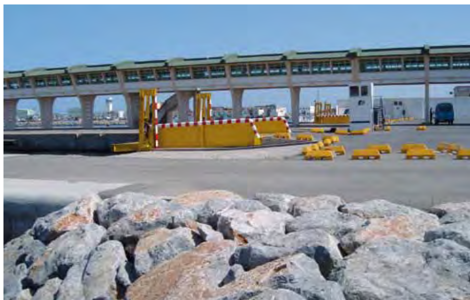
Port de Bni Ansar / Nador : des installations modernisées et bien dimensionnées
