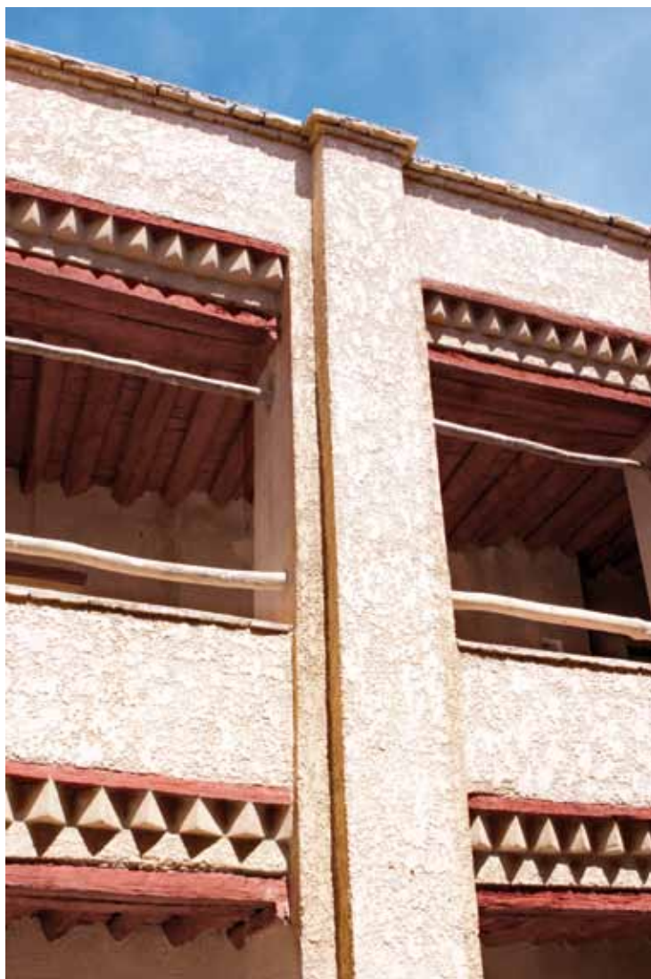
Exemple d'une façade de maison réhabilitée à Figuig
