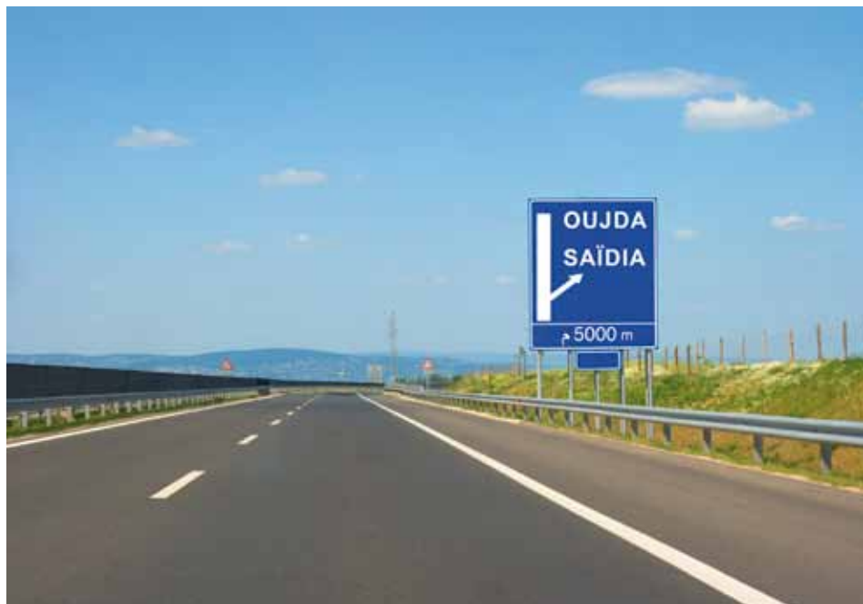
La nouvelle autoroute Fès-Oujda
