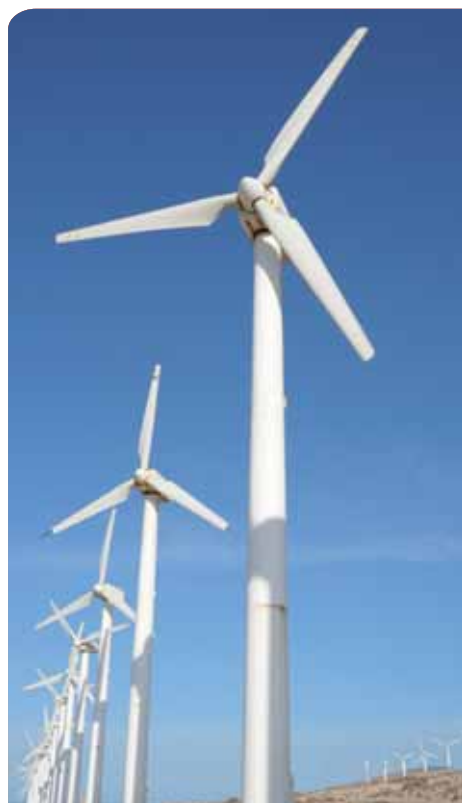
L'éolien est compatible avec les installations de grande dimension
