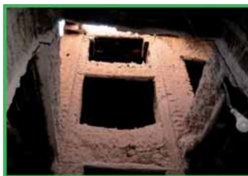
B/1- DÉGRADATION DE L'ENVELOPPE (cassures dues à l'érosion et au ruissellement/ la fissuration)
