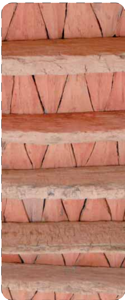
Plancher restauré, poutres et karnafs de palmier
