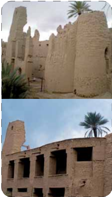
La muraille de la place Ajdir, avant et après restauration
