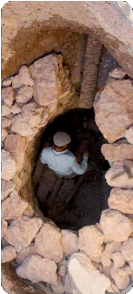
Préparation du four à chaux avant calcination (protection des murs)
