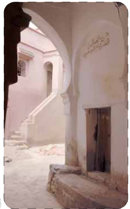
Réhabilitation en cours
