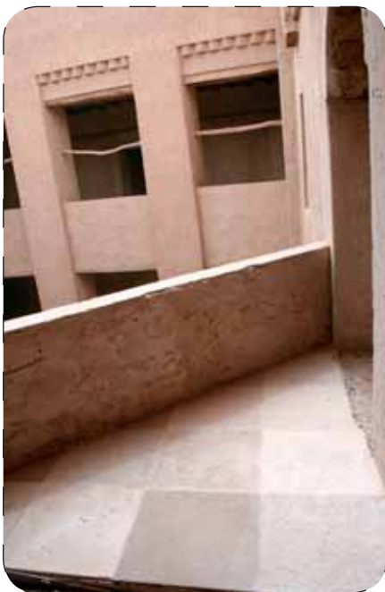
Sauvegarde du patrimoine : maison en restauration
