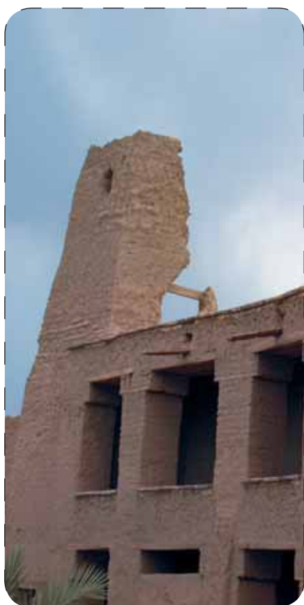
Restauration en cours de la Muraille d'Ajdîr
