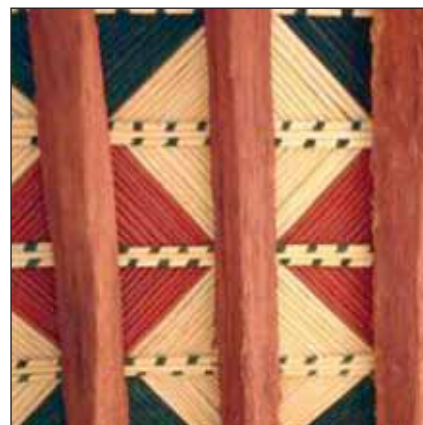
Solaio tipo A Plancher type B (poutres et (travi e karnef) baguettes en laurier rose) Solaio tipo B (travi e bacchette di oleandro)
