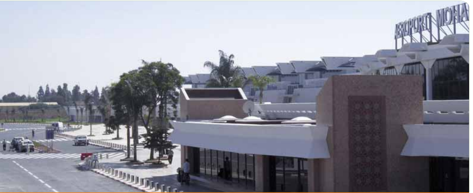
إقامة مركز لمراقبة العمليات مجهز بالوسائل الإعلامية بشكل كامل
