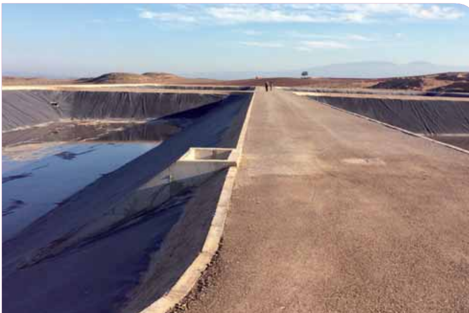
محطة تحويل الطاقة بواسطة الضخ بمدينة رأس الما التابعة للمكتب الوطني للكهرباء والماء الصالح للشرب
