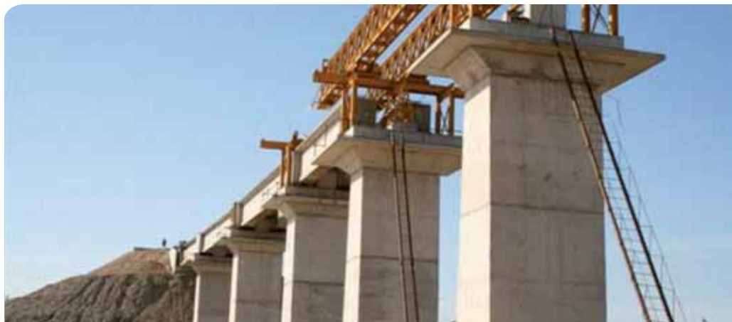
Le chantier de la ligne Taourirt - Nador bat son plein
