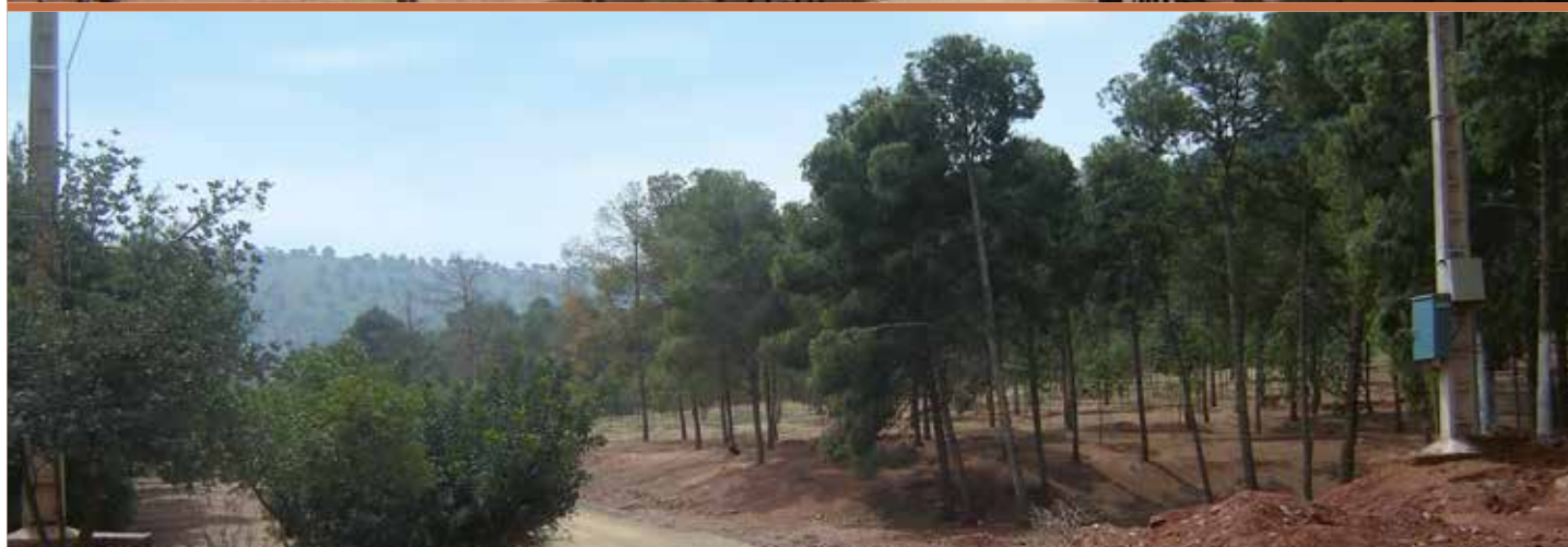
Aménagement de larges sentiers pédestres au sein de la forêt de Sidi Maâfa
