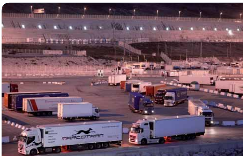
Plateforme d'interface logistique au port de Tanger Med
