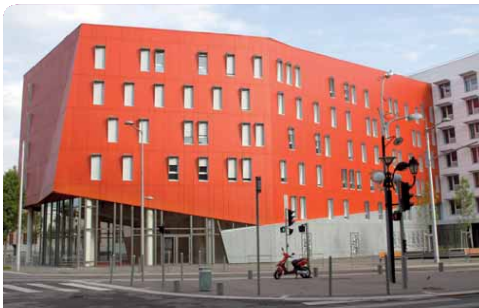
Un bâtiment de Sophia-Antipolis, vaste pôle universitaire de R&D de renommée mondiale (proche de la ville de Nice)
