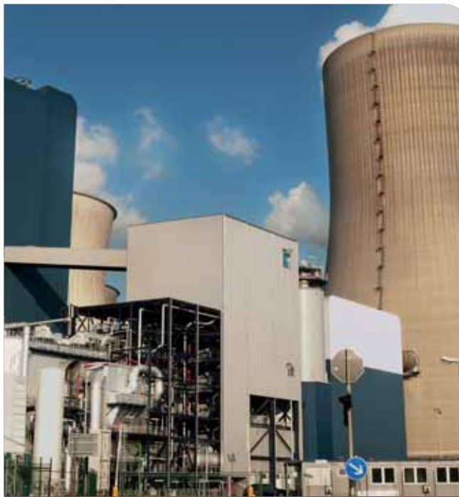
المحطات الكهربائية بالفحم : 40% من الكهرباء العالمية
