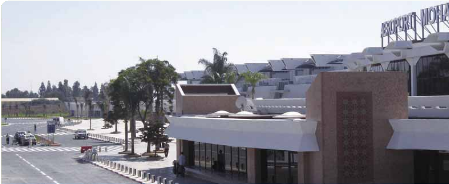
Mise en place d'un Centre de Contrôle des Opérations totalement informatisé à l'aéroport Mohammed V.
